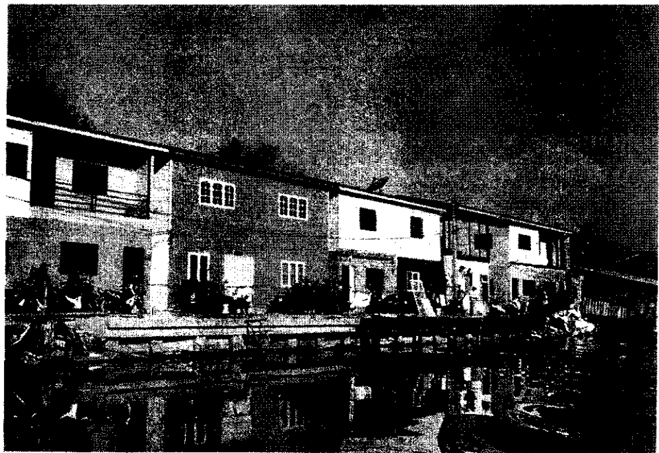
ชุมชนสะพานไม้ 2 หลังรื้อบ้านพื้นโคลงและสร้างใหม่
