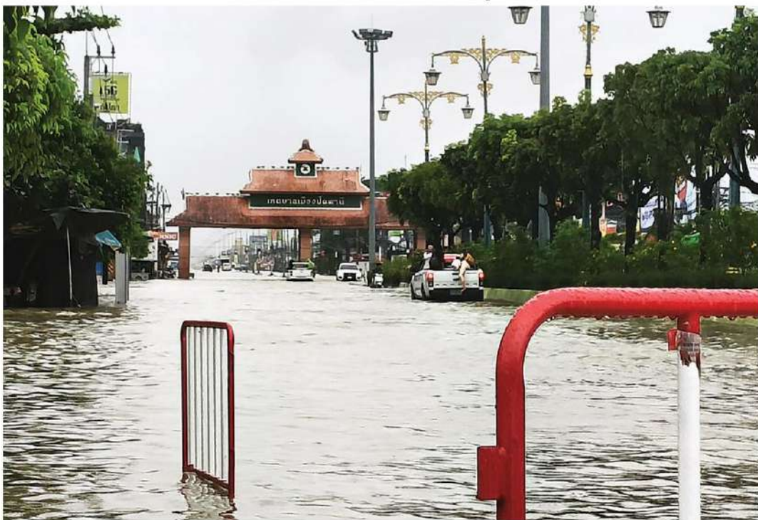
△ ปัตตานียังจม - สถานการณ์น้ำท่วมพื้นที่เขตเทศบาลเมืองปัตตานี เมื่อวันที่ 29 พ.ย. น้ำยังท่วมเป็นบริเวณกว้าง โดยผู้ว่าฯ ปัตตานีระดมทุกหน่วยช่วยเหลือประชาชนกว่า 6 แสนคนใน 12 อำเภอที่ได้รับผลกระทบจากอุทกภัย
