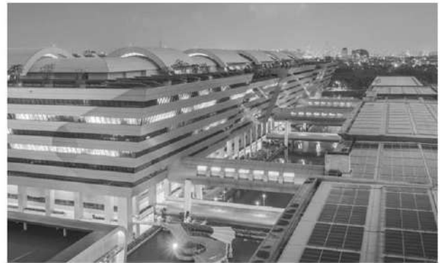
อาคารศูนย์ราชการใช้พื้นที่หลังคาติดตั้งโซลาร์เซลล์
