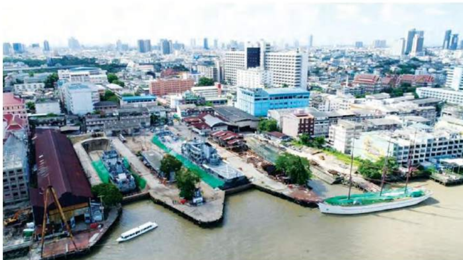
ที่ดินติดริมแม่น้ำเจ้าพระยา ที่บริษัท อู่กรุงเทพ จำกัด เปิดประมูล
