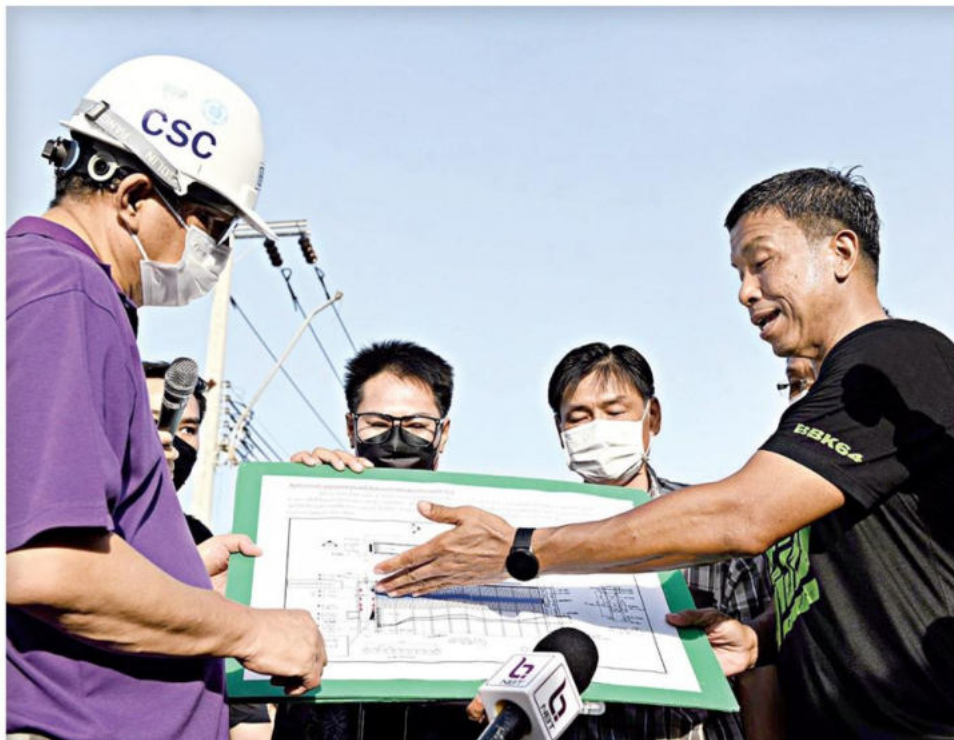
▲ ปัญหา...นายชัยชาติ สิทธิพันธุ์ ผู้ว่า กทม. ตรวจเยี่ยมโครงการก่อสร้างอุโมงค์ระบายน้ำบึงหนองบอน สู่เจ้าพระยาแก้ปัญหาสะพานคลองเล็งทรุดตัว บรรเทาความเดือดร้อนประชาชน เร่งให้เสร็จปลายปี 66
